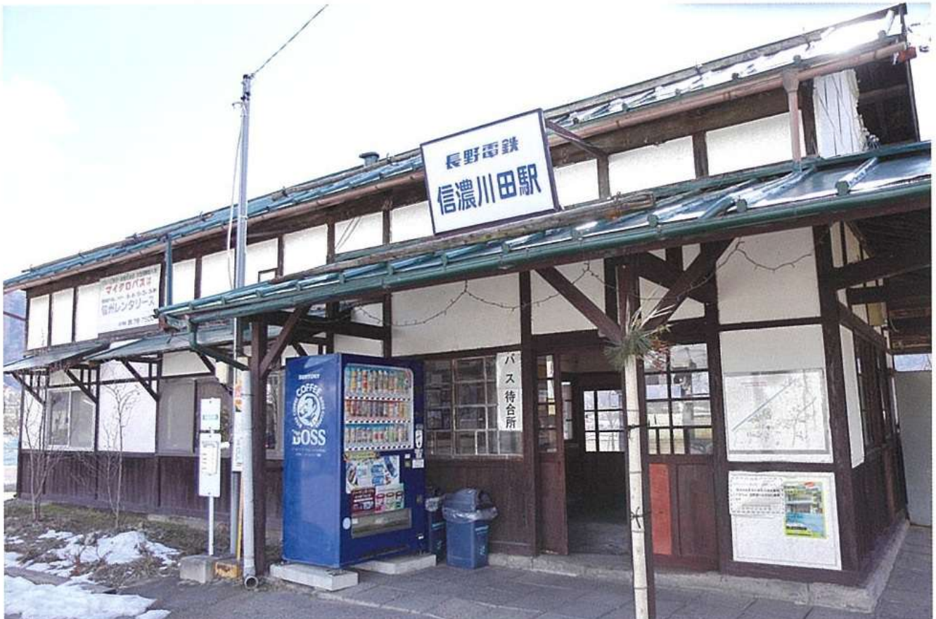
平成24年（2012）に廃駅となり、現在バス待合所となっている 信濃川田駅（長野市若穂川田）。長野空襲を伝える建物
