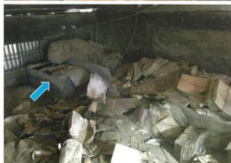
上：天井裏入口付近の資料発見状況 下：木箱の発見状況(矢印)
